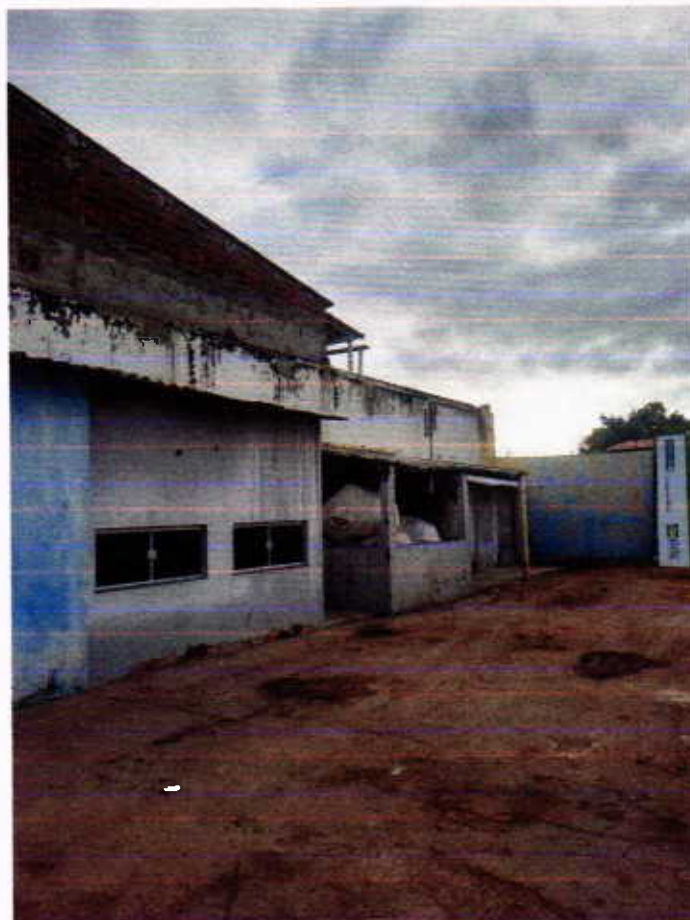
Figura 2: Vista geral da fachada interna do imóvel
